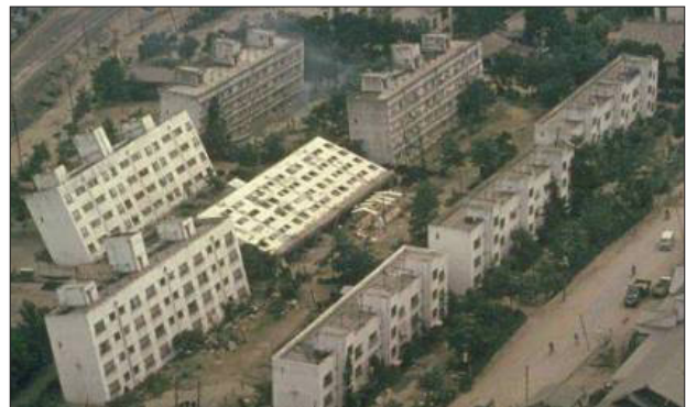
Abb.2: Das passiert, wenn Gebäude auf weichem Untergrund errichtet sind. (Ich, die Bibliothek des Earthquake Engineering Research Center an der University of California in Berkeley, und Urheber dieses Bildes, überlasse es hiermit der Öffentlichkeit. Dies gilt weltweit. Ich erlaube jedweder Einrichtung die bedingungslose Nutzung für jegliche Zwecke, es sei denn, die jeweilige Rechtssprechung macht andere Absprachen erforderlich.)
